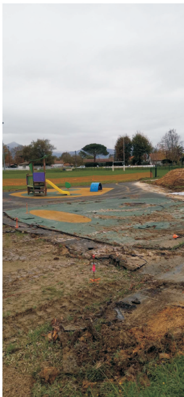
Photo de l'avancement des travaux
